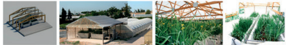
Imágenes de la planta piloto con 6 HAFSH de 1,5 x 3 m cada uno, ubicada en el IRTA-Cabrils (Barcelona)
